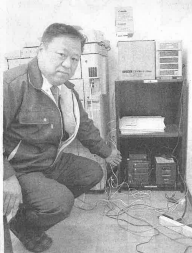
津波などによる浸水に備え、企業データのバックアップを上層階に設置したエフ・ケイ メカニクスの古川克己社長
